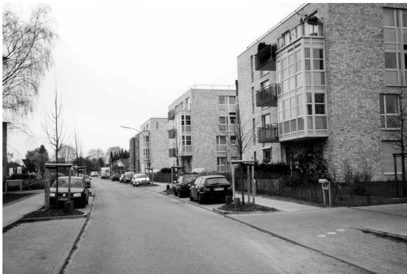
Abb. 13: Erschließungsstraße und Parkstände im öffentlichen Straßenraum
